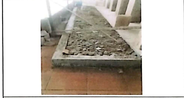
10 M2 DE PISO DE PASILLO SANITARIOS MODULO 1
