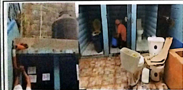
MANTENIMIENTO BAJADA PLUVIAL Y PÁNUELO EN LOSA DE CABINA DE SANITARIOS MODULO 2 Y SUSTITUCION DE "3" INODOROS SANITARIOS MODULO 2
