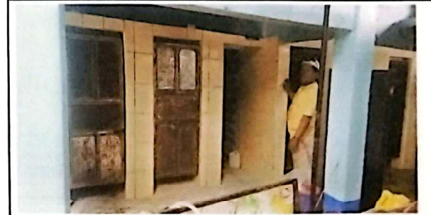
MANTENIMIENTO DE MUROS TABIQUE DE "14" CABINAS DE SANITARIOS MODULO 1 Y MANTENIMIENTO DE "14" PUERTAS METALICAS DE CABINA DE SANITARIOS MODULO 1
