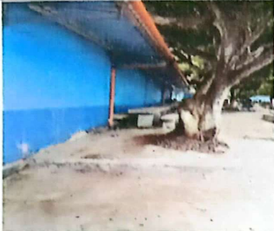
Foto 1: Suministro de lamina troqueleada aluzinc calibre 26
