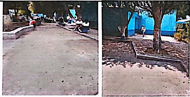
Foto 3: Suministro de piso de concreto para exterior.
