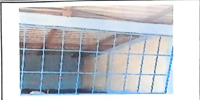
Foto 1: Suministro y reparacion de muro de block
