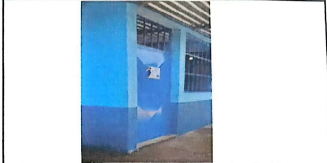
Foto 2: Sustitucion de puerta metalica
