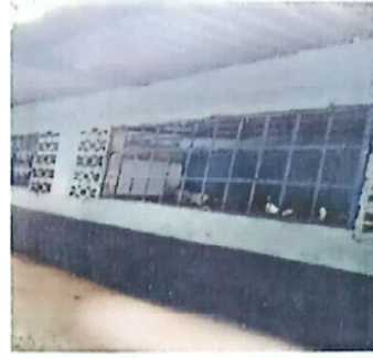
Foto 2: Suministro y sustitucion de balcones de metal
