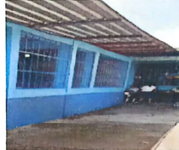
Foto 4: Suministro y sustitucion de balcones de metal
