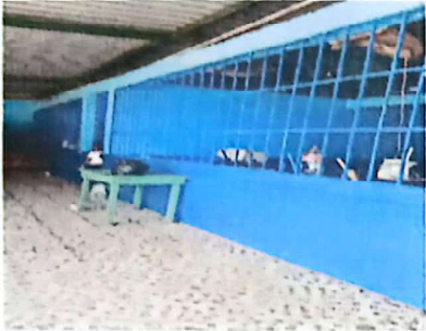
Foto 3: Suministro y sustitucion de balcones de metal
