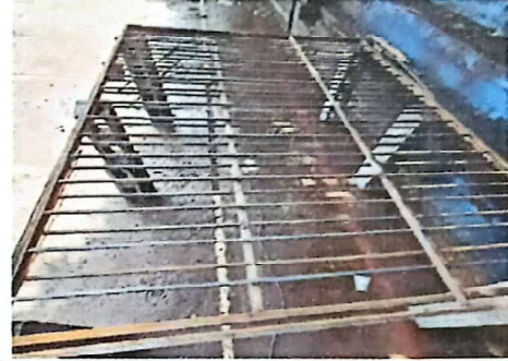
Foto 4: Suministro y sustitucion de balcones de metal
