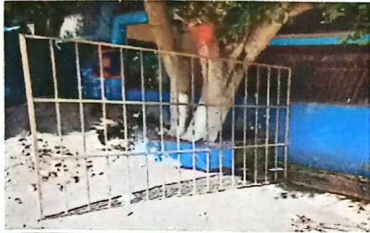
Foto 3: Suministro y sustitucion de balcones de metal
