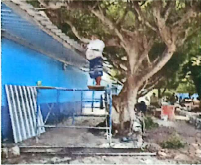
Foto 1: Suministro de lamina troqueleada aluzinc calibre 26
