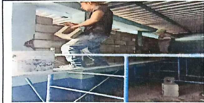
Foto 1: Suministro y reparación de muro de block
