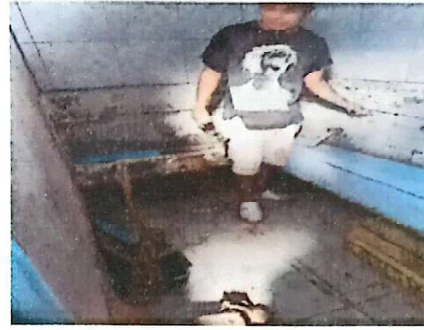
FOTO 4: Suministro y sustitución de azulejos para migitorios
