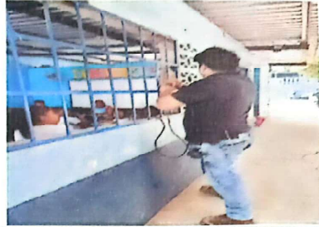
Foto 2: Suministro y sustitucion de balcones de metal
