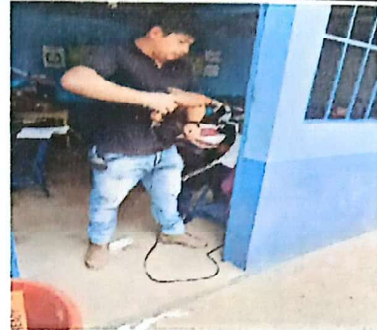
Foto 2: Sustitución de puerta metálica
