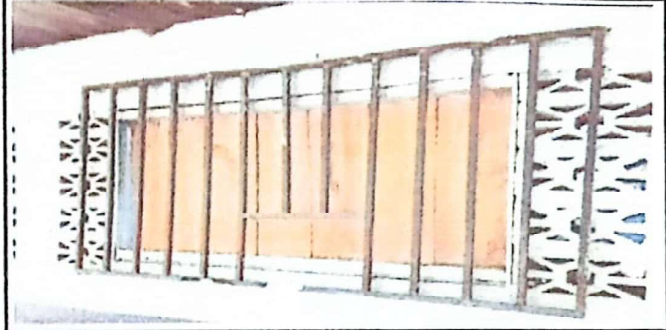
Foto 2: Suministro y sustitucion de balcones de metal
