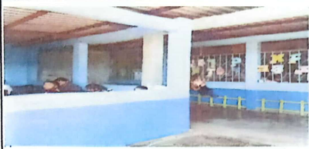
Foto 1: Suministro y reparación de muro de block
