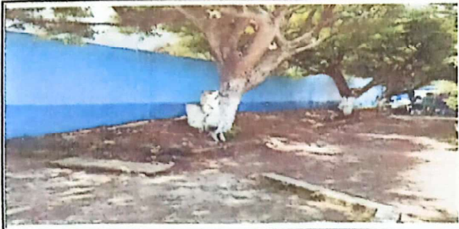
Foto 1: Suministro de lamina troqueleada aluzinc calibre 26
