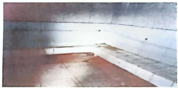
Foto 4: Suministro y sustitución de azulejos para migitorios
