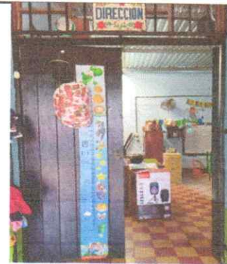
SUSTITUCIÓN DE PUERTA
