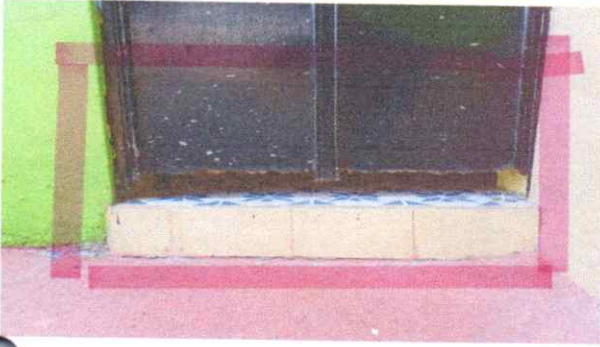
REPARACION DE PUERTA DE BAÑO DE NIÑOS
