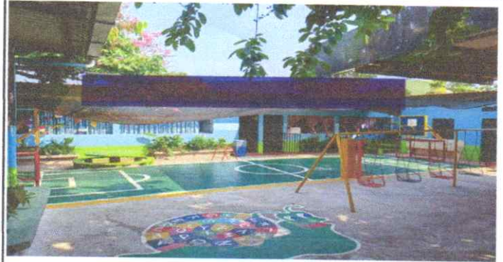
INSTALACIÓN DE ESTRUCTURA METÁLICA PARA CUBIERTA DE LÁMINA
