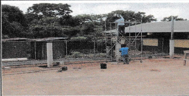
Foto 1: Suministro e instalación de cimentación para techo de patio
