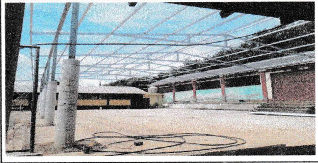
Foto 2: Suministro e instalación de estructura de metálica de patio
