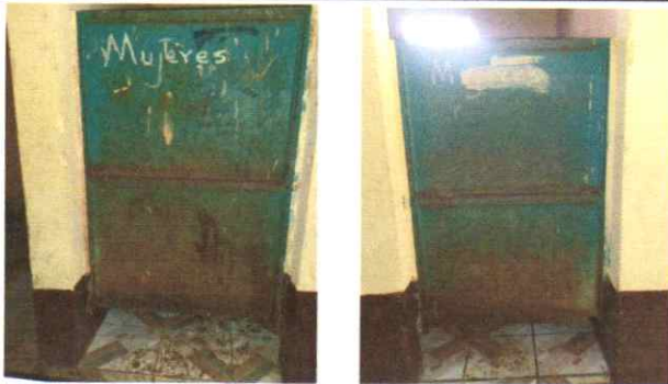
Sustitución de puertas de metal área de baños 0.88 x 1.60 metros.
