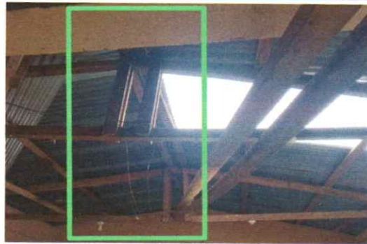
Reparación del sistema eléctrico Aula 1 y 2.
