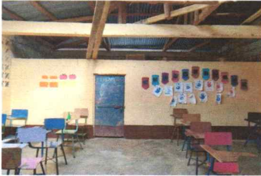
Sustitución de puerta área de Bodega y Pozo.
