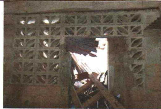
Sustitución de paredes, bodega de almacenamiento 28.08 m2.
