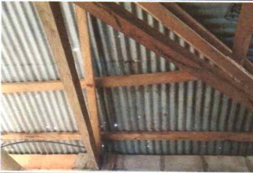
Sustitución de estructura de madera por metal y de cubierta de lámina por lámina troquelada C26 Aula 1 y 2.
