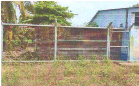
Foto 3: Suministro e instalación de Estructura metálica.
