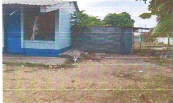
Suministro e instalación de estructura metálica y cubierta laminar.
