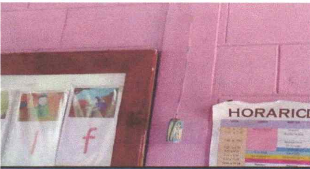
Sustitución de toma corrientes.
