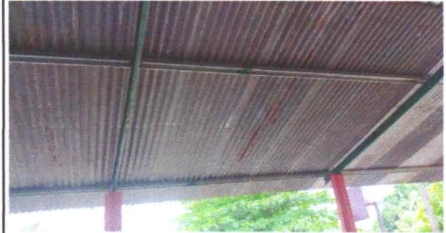
Mantenimiento de estructura metálica con pintura anticorrosiva
