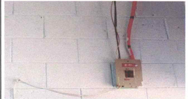
Sustitución flippon sistema eléctrico Módulo 1 y 2
