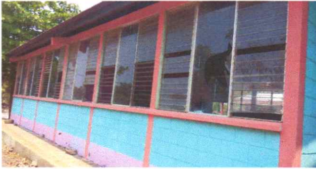
Sustitución de ventanas de hierro Módulo 1 y 2
