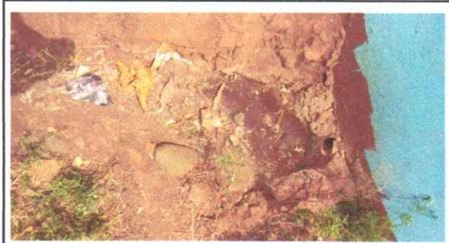
Sustitución de tubería PVC 3 líneas principales
