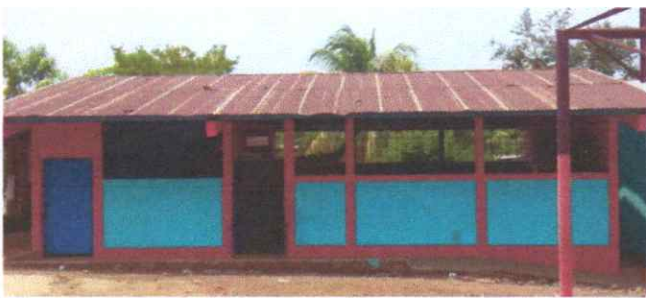
Sustitución de lámina troquelada c 26 Módulo 1 y 2
