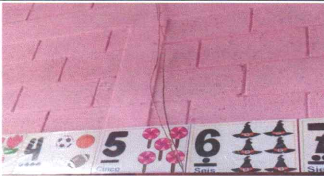
Reparación de sistema eléctrico Módulo 1 y 2
