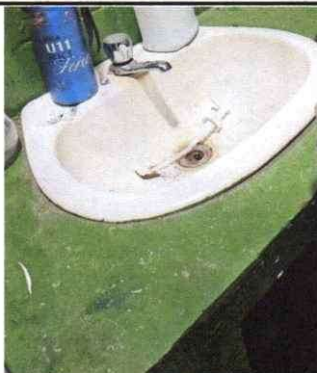
Foto 7: Suministro e instalación de lavamanos de baño de maestros
