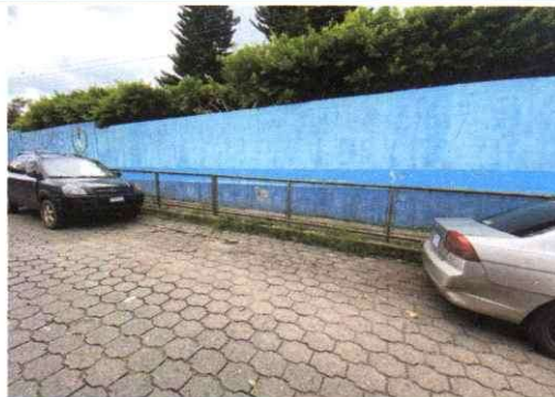
Foto 8: Suministro y aplicación de pintura exterior
