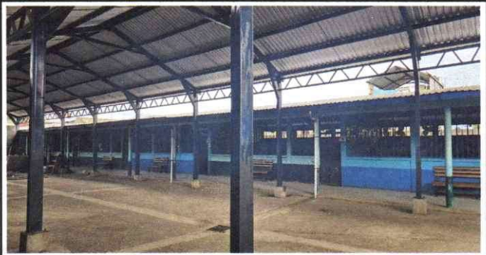
Foto 6: Suministro e instalación de lamina transparente en el patio interno
