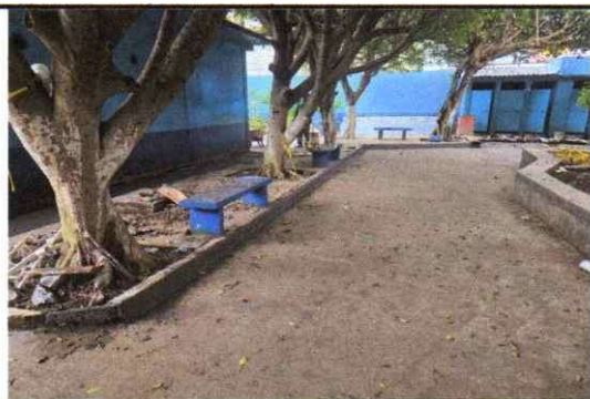
Foto 11: Suministro y reparación de jardines
