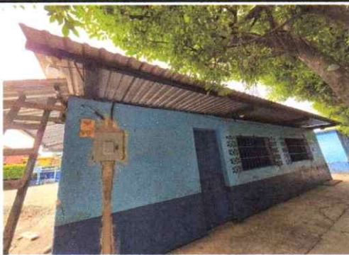
Foto 5: Suministro e instalación de canales
