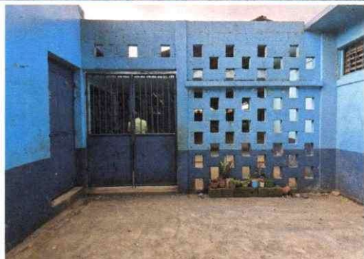
Foto 9: Suministro y reparación porton de entrada
