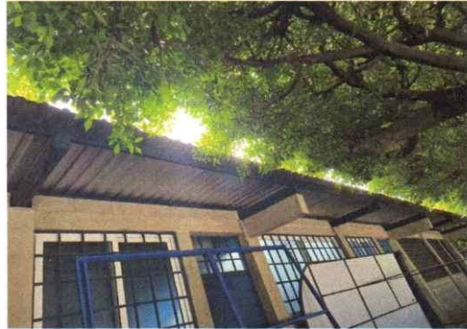
Foto 2: Suministro e instalación de lamina troquelada c26 en el modulo de computación
