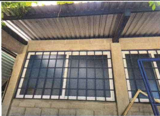
Foto 3: Suministro e instalacion de sistema electrico patio interno
