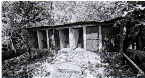
Sustitucion de letrinas
