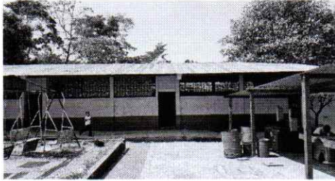
Sustitucion de indoors , Sustitucion de muro y cuneta de agua pluvial
