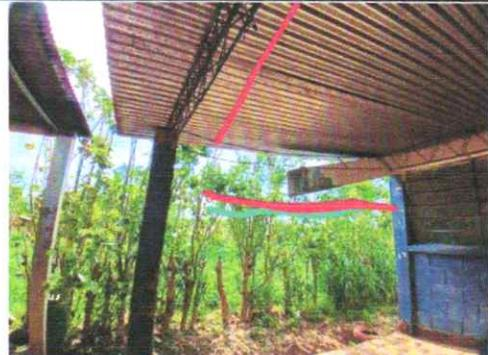
Suministro e instalación de estructura y soportes de metal para escenario, Sustitución de lámina, por lámina troquelada Calibre 26 para escenario.
