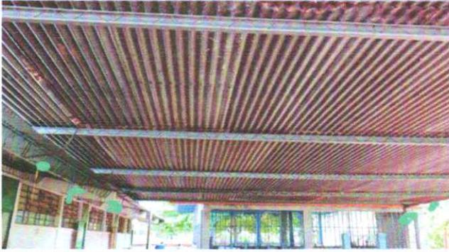
Mantenimiento a estructura y soportes de metal para el salón de actos, Sustitución de lámina, por lámina troquelada Calibre 26 para salón de actos.
