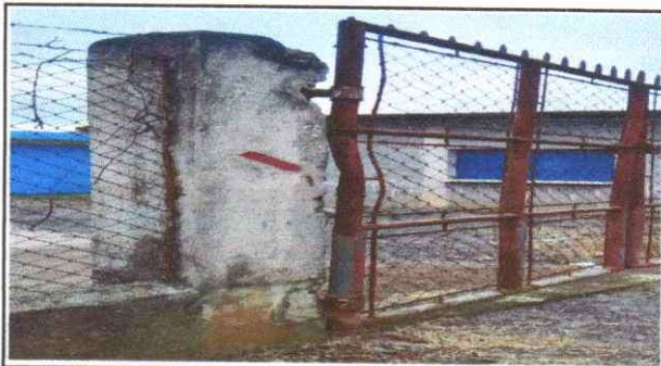
Sustitución de pórtón de metal
