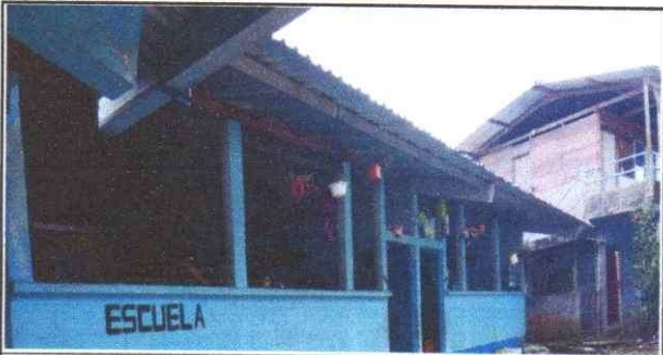
Sustitución de Balcones
