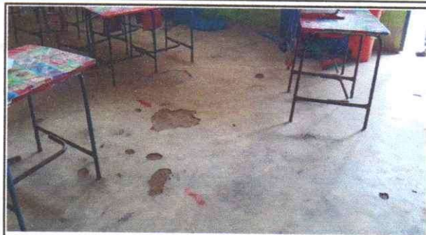
Sustitución de Piso Cerámico
