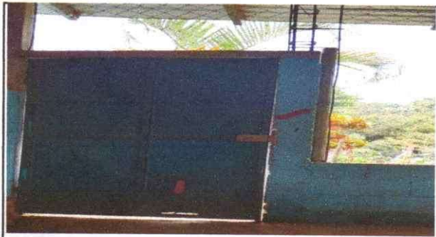
Sustitución de puerta
