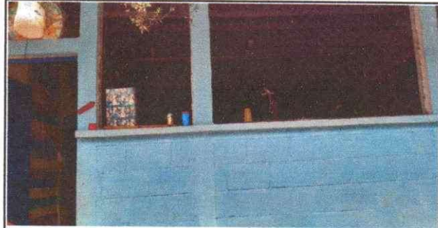
Sustitución de malla por perclana de vidrio
