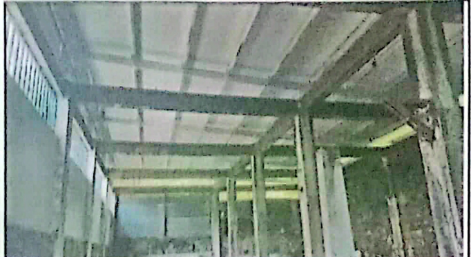
Foto 2: SUMINISTRO E INSTALACION DE LAMINA MAXALUM C26(0.40MM) OND G80 MDA
