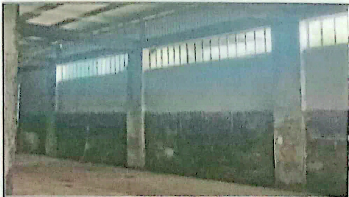
Foto 3: SUMINISTRO E INSTALACION DE MURO DE BLOCK PARA AULA
