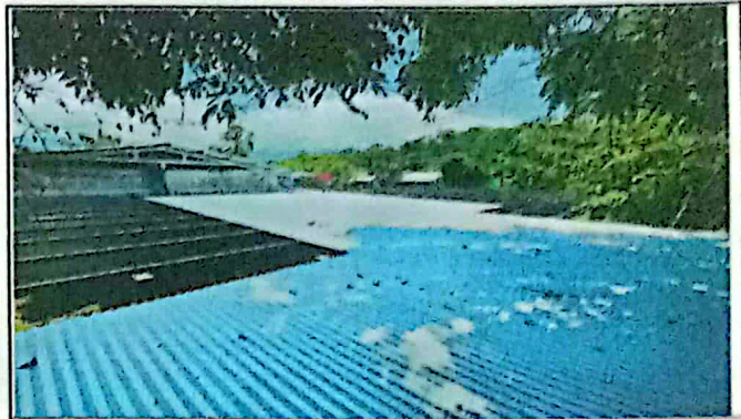
Foto 2: suministro e instalacion de lamina maxalum (c26) (0.40MM) OND G80 MDA
