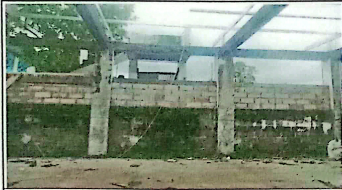
Foto 3: suministro e instalacion de muro de block para aula
