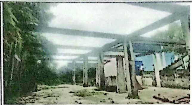
FOTO 1: SUMINISTRO DE INSTALACIÓN DE 395 M2 DE ESTRUCTURA METALICA
