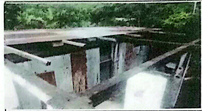
FOTO 1: SUSTITUCIÓN DE LAMINA POR LAMINA DE 395 M2 MAXALUM C26 (0.40mm)OND G80 AZM150 MDA.
