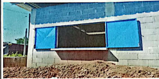
Foto 2: Sustrucción de ventana
