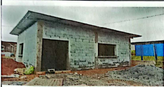
Foto 1: Sustrucción de Muro de Block.
