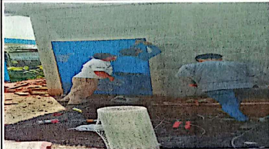
Foto 4: Sustrucción de puerta
