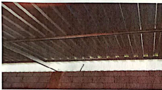
Foto 3: Instalación de Estructura Metálica.
