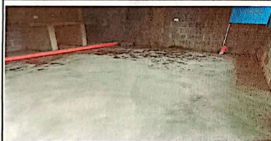
Foto 5: Sustrucción de piso de concreto.
