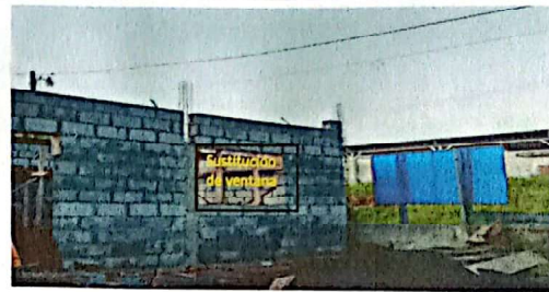
Foto 2: sustitución de ventana.
