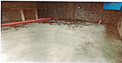
Foto 5: Instalación de piso de concreto.
