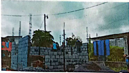
Foto 1: Sustrucción de muro de block
