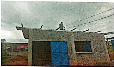
fotografía 3: Instalación de estructura metálica, con lámina alucinc calibre 26.
