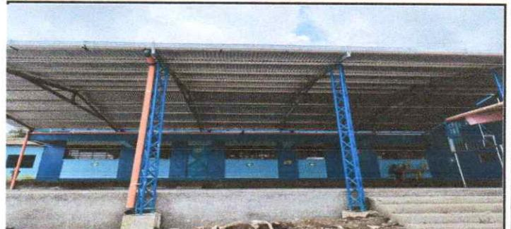
Foto 4: Suministro e instalación de lámina C26 finalizado al 100%
