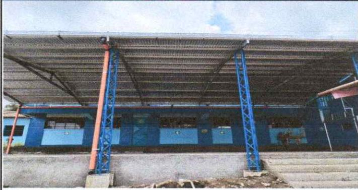
Foto 1. Instalación de canales y bajadas de agua parte frontal
