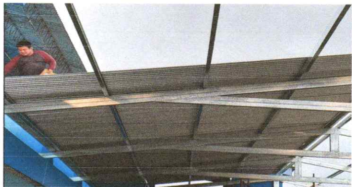
Foto 4: Suministro e instalación de Cubierta de lámina C 26
