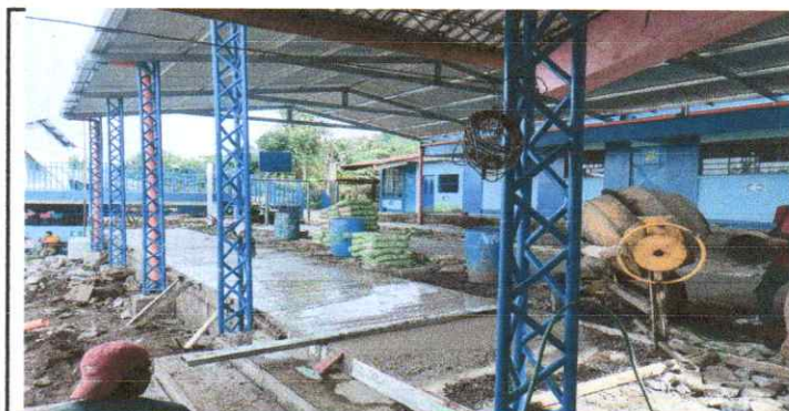
Foto 6: Seguimiento de fundición de cimentación en cancha
