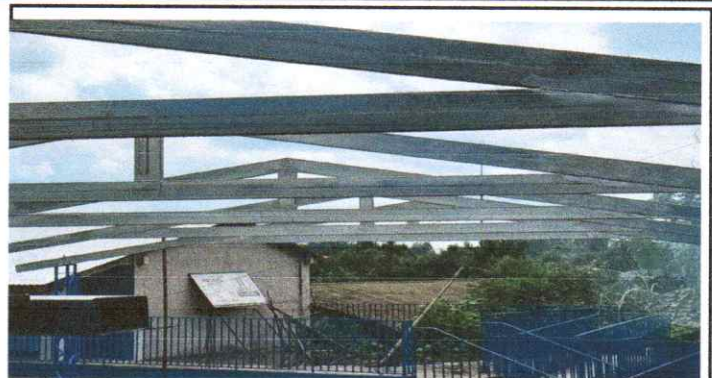
Foto 2: Suministro e instalación de estructura metálica
