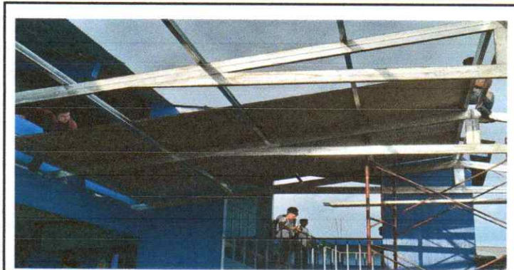
Foto 3: Suministro e instalación de cubierta de lámina C26
