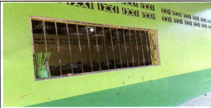
Mantenimiento de balcones de metal ( lijado, cepillado y aplicación de pintura anticorrosiva).
