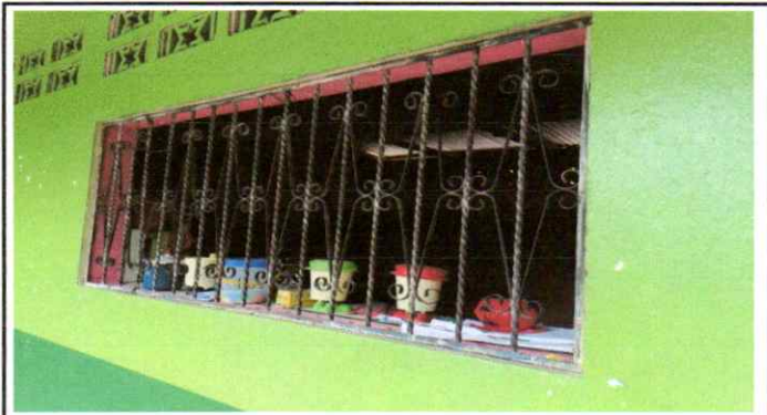
Mantenimiento de balcones de metal ( lijado, cepillado y aplicación de pintura anticorrosiva).
