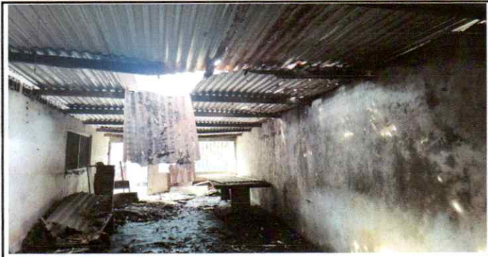
Sustitución de estructura metálica e instalación de lámina troquelada calibre 26 para área infantil.
