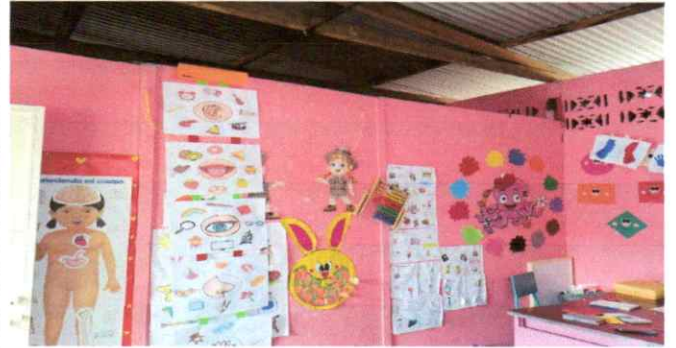
Sumistro e instalación de muro de block de divisiones intermedias.
