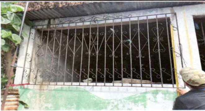
Suministro e instalación de cortina metálica.
