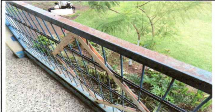
Mantenimiento de baranda metálica (lijado, cepillado y aplicación de pintura anticorrosiva)
