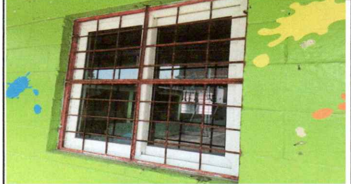
Suministro e instalación de balcones de metal.
