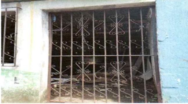
Suministro e instalación de puertas de metal.
