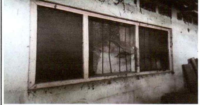
Suministro y cellado de ventanas.
