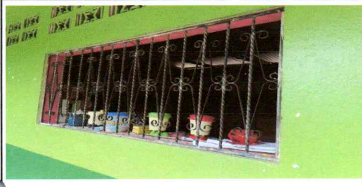
Suministro e instalación de ventanas de PVC
