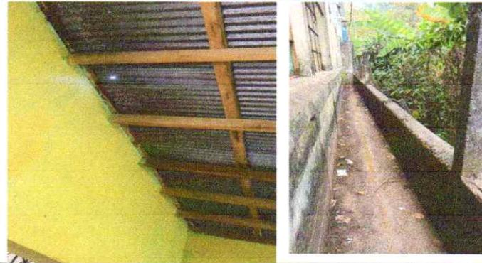
Sustitución de estructura portante por tubo estructural galvanizado
