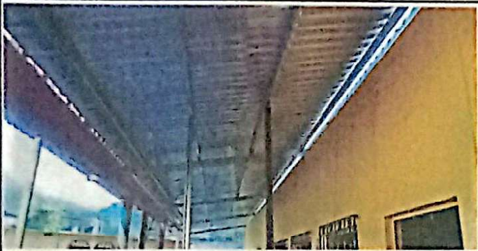
Mantenimiento sustitucion estructura de madera por estructura metalica galvanizada. Mantenimiento sustitucion de cubierta de lámina C26
