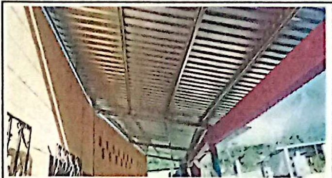
Mantenimiento sustitucion estructura de madera por estructura metalica galvanizada. Mantenimiento sustitucion de cubierta de lámina C26
