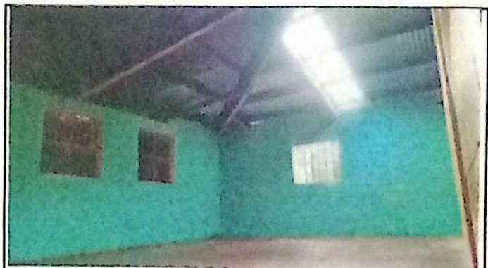
Mantenimiento sustitución estructura de madera por estructura metálica galvanizada. Mantenimiento sustitución de cubierta de lámina C26
