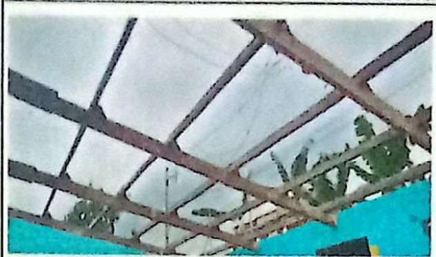
Mantenimiento sustitución estructura de madera por estructura metálica galvanizada. Mantenimiento sustitución de cubierta de lámina C26
