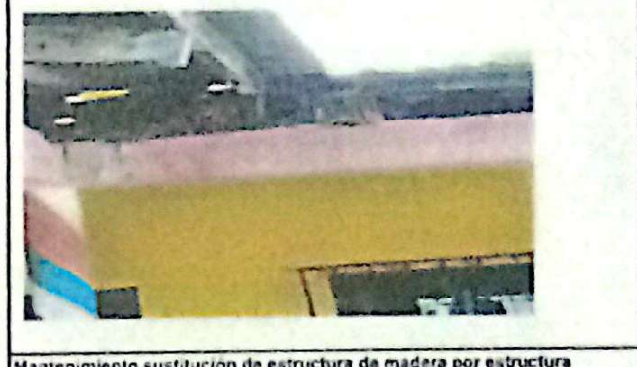
Mantenimiento sustitución de estructura de madera por estructura metálica galvanizada. Mantenimiento sustitución de cubierta de lámina C26
