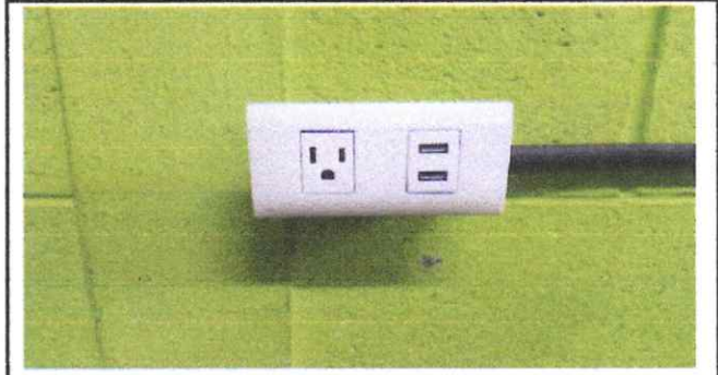
Foto 4: MODERNIZANDO CON SUMINISTRO DE TOMACORRIENTES CON USB.
