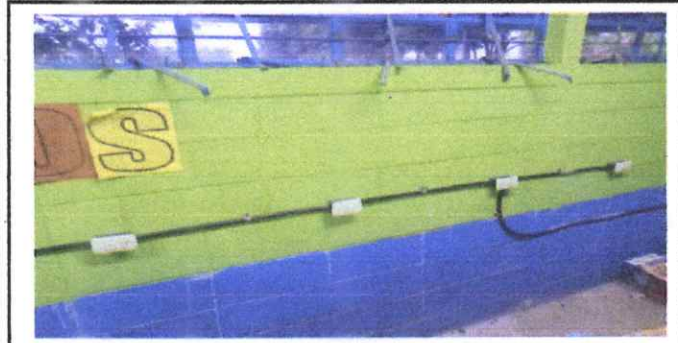
Foto 3: INSSTALACIÓN DE TOMACORRIENTES , DUCTO, CXABLEADO
