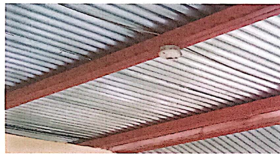
Sustitución de plafoneras, ducto, cableado, focos.
