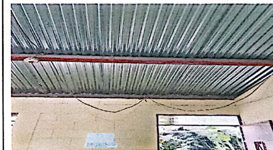
Sustitución de plafoneras, ducto, cableado, focos.
