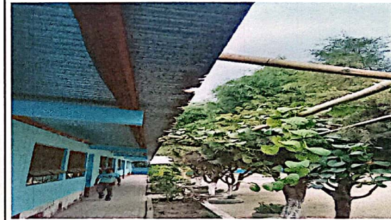
Suministro de lámina acanalada calibre 24, vigas metálicas, corredor del modulo de aulas.
