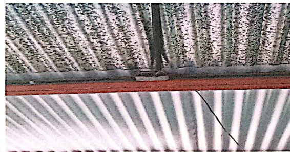
Sustitución de plafoneras, ducto, cableado, focos.
