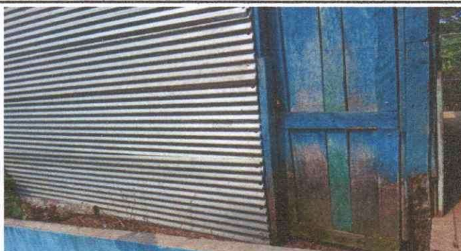
Sustitución de puerta
