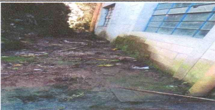
sustitucion de canaletas(sustitucion de ocho metros de canaleta y 15 metros de pared)
