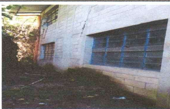
sustitucion de canaletas(sustitucion de ocho metros de canaleta y 15 metros de pared)
