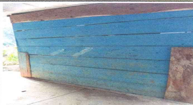
Sustitución de estructura de techo
