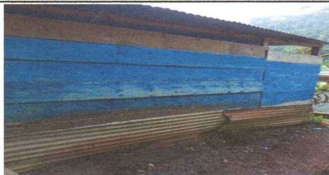
Sustitución de cerramiento por muro prefabricado con estructura metálica
