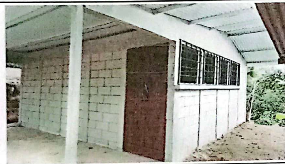
Suministro e instalacion de puerta de metal con chapa Yale 1x2.5 m.
