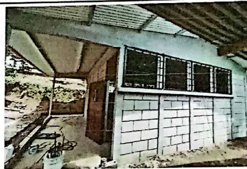
Suministro e instalación de ventana 1x1 m.
