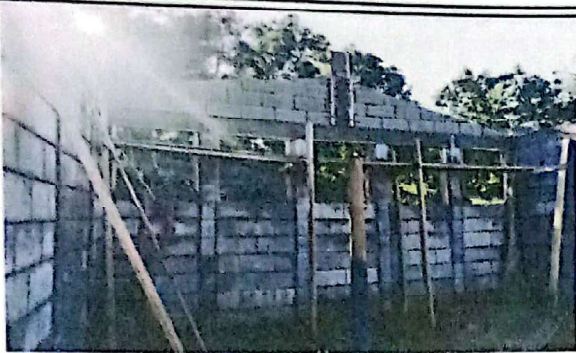
Suministro e instalación de paredes prefabricadas para aula.
