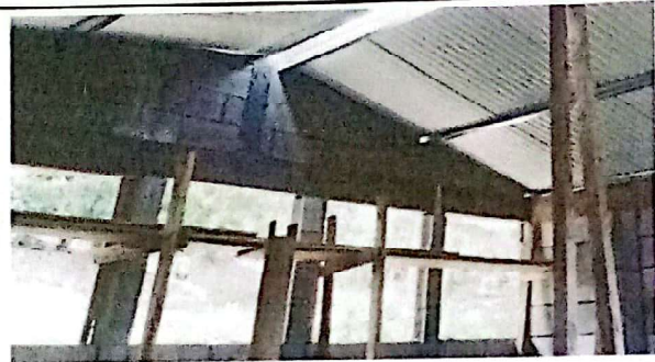
Suministro e instalación de ventana 1x1 m.
