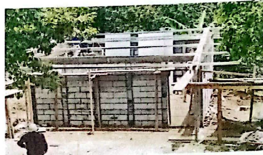
Suministro e instalación de estructura para techo con techo de lamina troquelada/acanalada aluzinc cal 26
