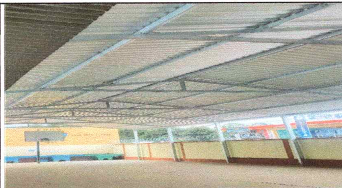
Foto 3: Finalización de techo parte interior
