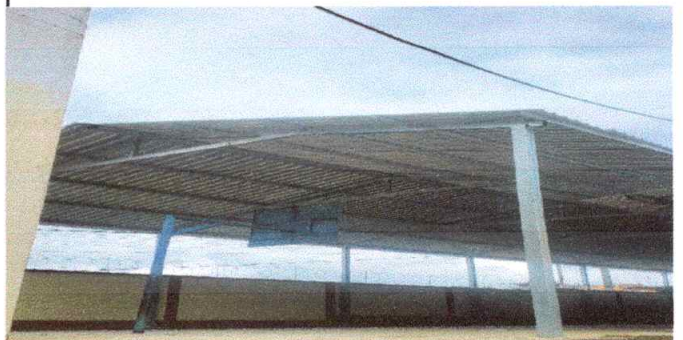
Foto 1: Finalización de techo parte interior
