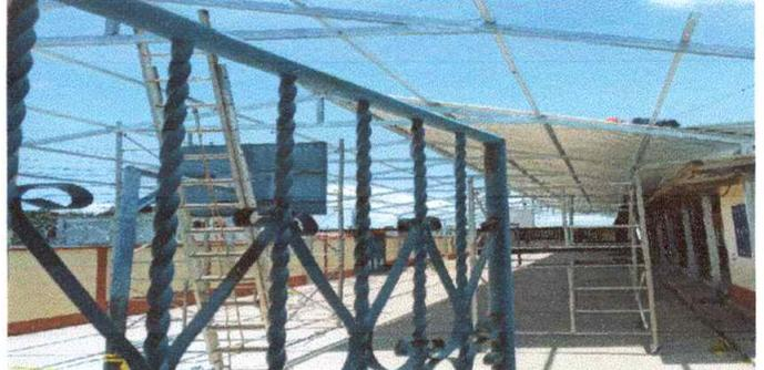
Foto 2: Iniciacion de instalación de laminas
