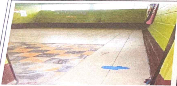
Foto 5: COLOCACIÓN DE PISO EN MÓDULOS DE AULAS
