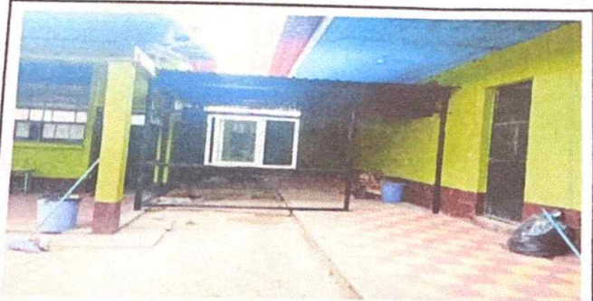
Foto 6: AMPLIACIÓN DE COCINA
