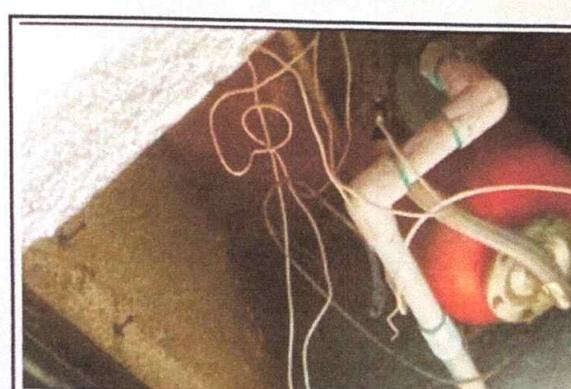
Foto 6: BOMBA DE AGUA EN MAL ESTADO
