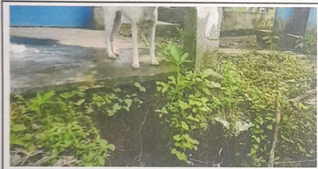
Suministro y sustitucion de muro de contencion
