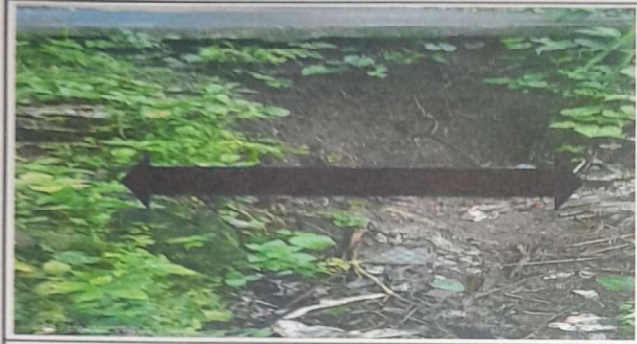
Suministro y sustitucion de muro de contencion
