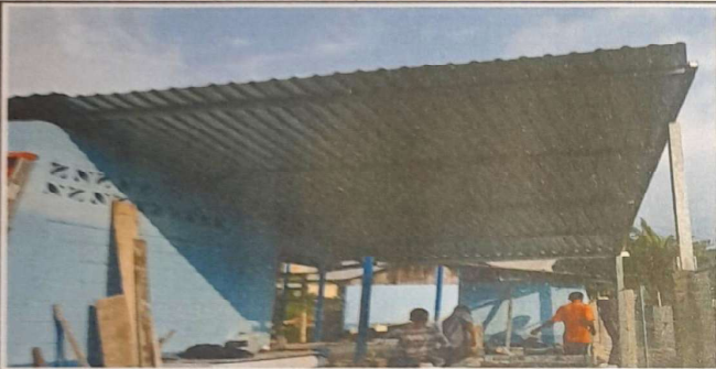
SUSTITUCION DE ESTRUCTURA PORTANTE + ENTECHADO DE AREA DE PILA
