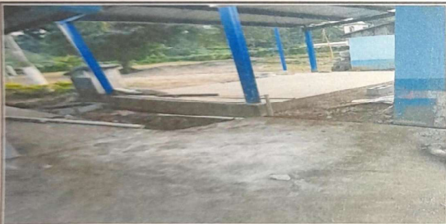
REPARACION DE CAJA DE CONCRETO DE DESFOGUE
