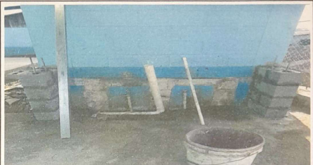
REPARACION DE LAVAMANO DE CONCRETO, TUBERIA DE DRENAJE
