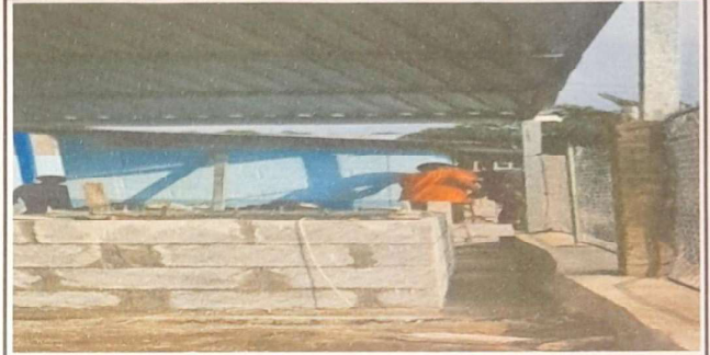
SUSTITUCION PILA DE CONCRETO
