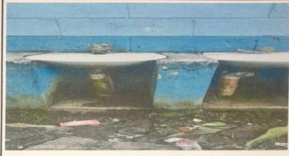
REPARACION DE LAVAMANOS DE CONCRETO, TUBERIA DE DRENAJE
