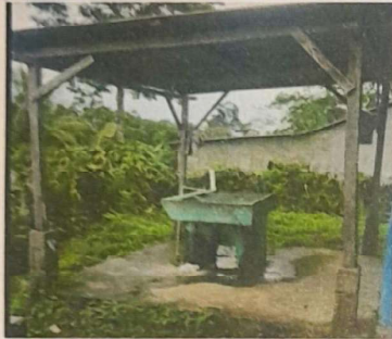
SUSTITUCION DE ESTRUCTURA PORTANTE + ENTECHADO DE AREA DE PILA
