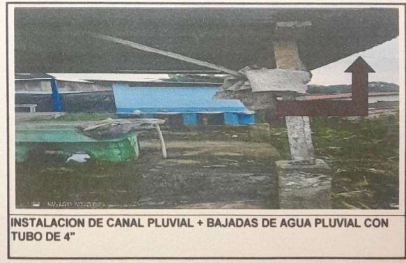
INSTALACION DE TUBERIA DE 4" PARA DESFOGUE
