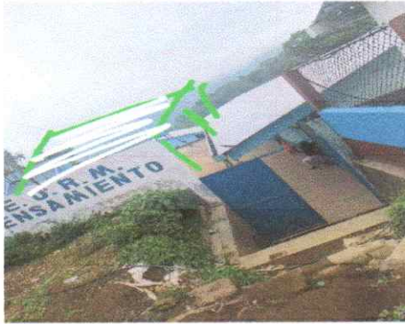
Sustitucion de lamina troquelada calibre 26
