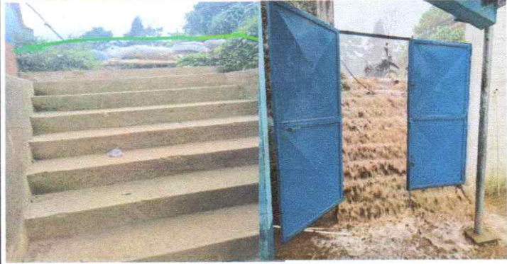
Mantenimiento de gradas de ingreso
