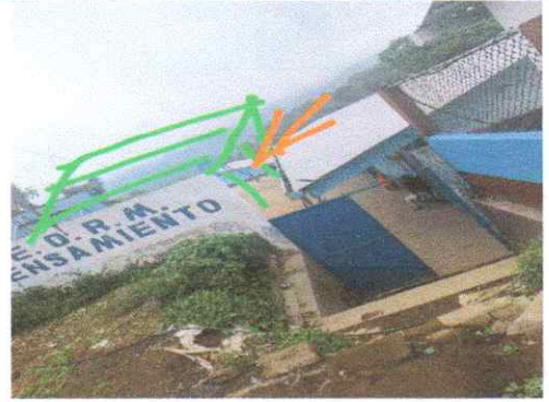
Sustitucion de lamina troquelada calibre 26
