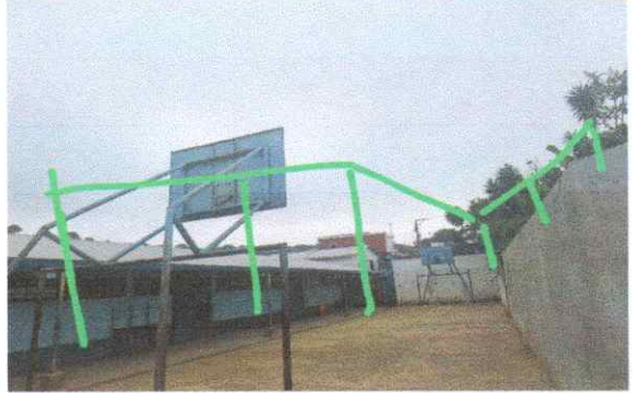
Sustitucion de estructura metálica en area recreativa.
