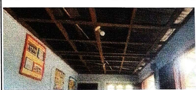
suministro y fabricacion de estructura melatica con costaneras.
