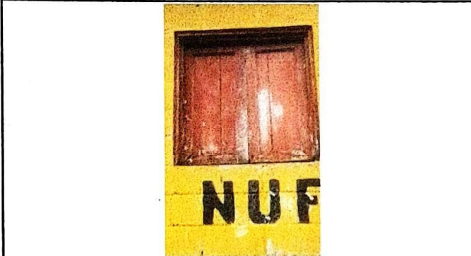
suministro e instalación de ventanas de U.P.V.C corredizas
