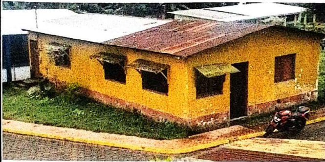
suministro e instalación de bubierta metalica con lamina troquelada calibre 26.
