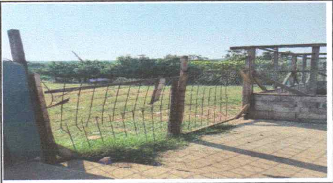
sustitucion de estructura de porton
