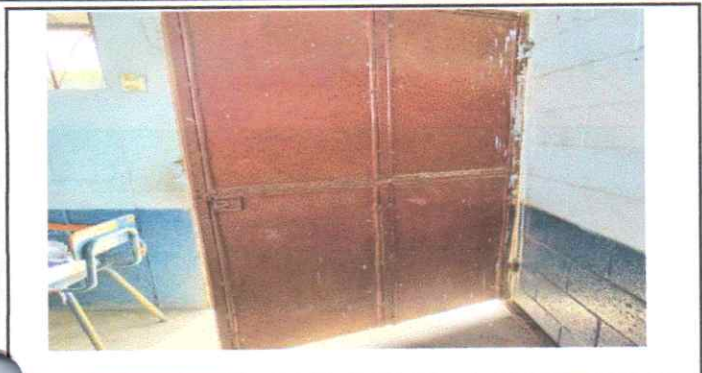
Sustitución de estructura metálica, Sustitución de puertas
