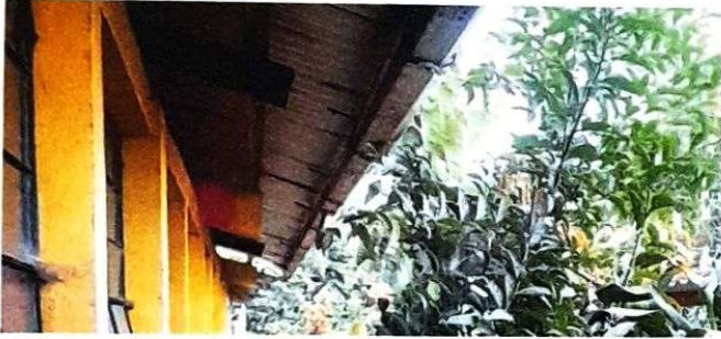
Foto 1: Área del techo donde se instalaría canal
