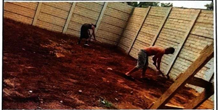
Foto 2: Área donde se instalaba el muro perimetral
