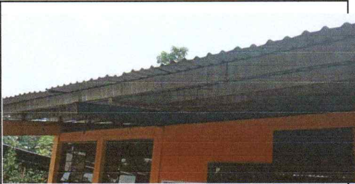
Reparación de Canales
