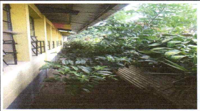
Reparación de muros perimetral
