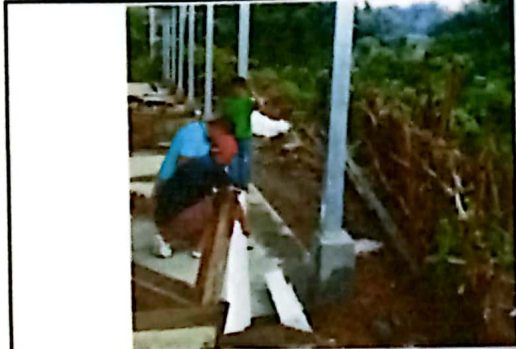
FOTO 2: SUMINISTRO E INSTALACIÓN DE CANALES DE PVC 40 MTS
