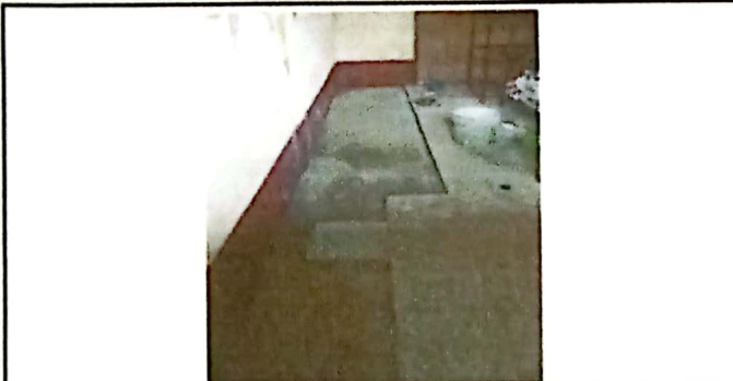
FOTO 3: SUSTITUCIÓN DE PISO DE TORTA DE CONCRETO POR GRANITO 63 M2
