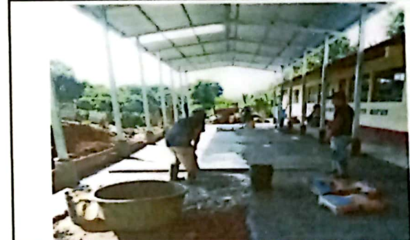
Foto 4: SUMINISTRO E INSTALACION DE DE PISO DE CONCRETO EN AREA DE PATIO 104 M2
