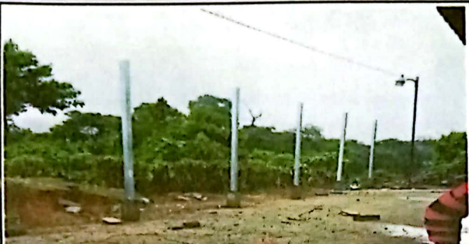
Foto 1: SUMINISTRO E INSTALACIÓN DE ESTRUCTURA METALICA PARA CUBIERTA DE PATIO 104 M2
