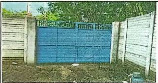
Foto 3: VISTA DEL POTÓN DE METAL FINALIZADO
