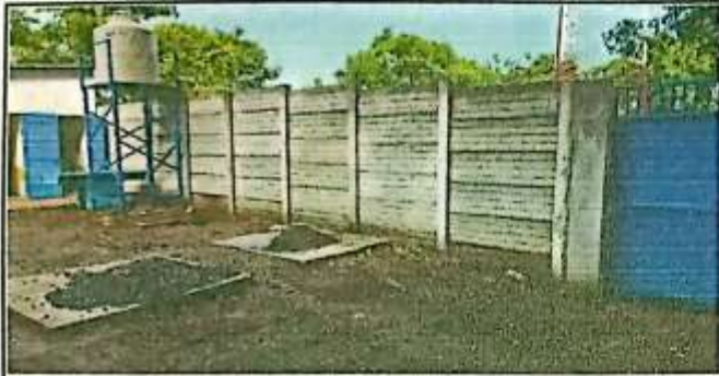
Foto 1: VISTA DE LA PARED FINALIZADO
