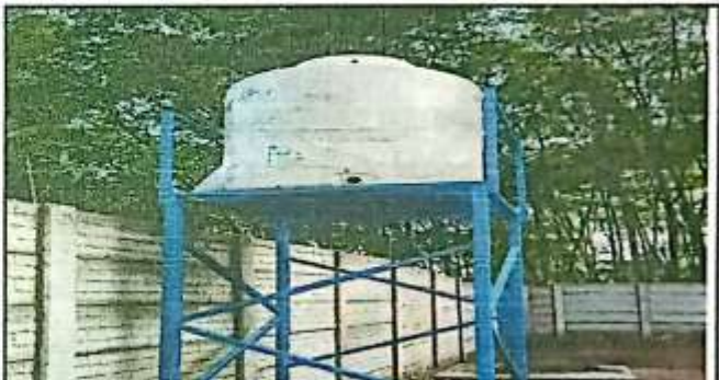
Foto 4: VISTA DE LA BASE DE METAL PARA EL ROTOPLAS
