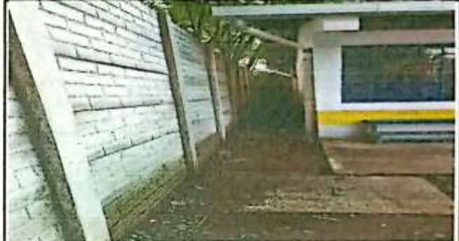
Foto 2: VISTA DE LA PARED FINALIZADO
