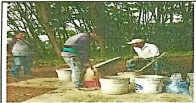
Foto 1: VISTA PREPARANDO LA MEZCLA PARA EL SIMIENTO DE LA PARED
