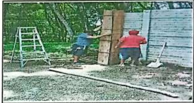
Foto 2: VISTA TRABAJANDO EL MURO PERIMETRAL
