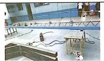
Foto 4: SOLDADURA DE TIRANTES DE COSTANERAS DE ESTRUCTURALES
