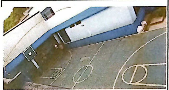
TECHADO DE AREA CON LAMINA Y ESTRUCTURA DE METAL
