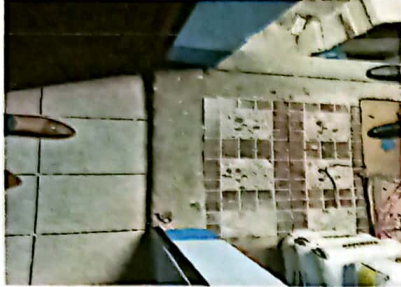
Foto 1: Colocando piso cerámico del corredor
