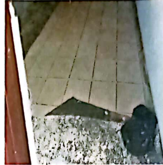
Foto 2: Colocando piso de dirección
