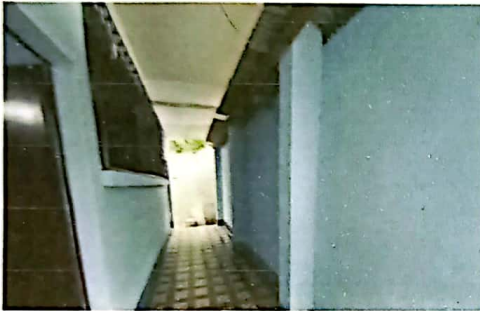
Foto 3: Finalizando la pintura de las aulas paredes exteriores.
