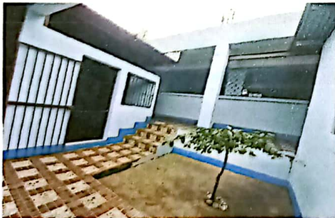
Foto 5: Pintura de aulas terminada
