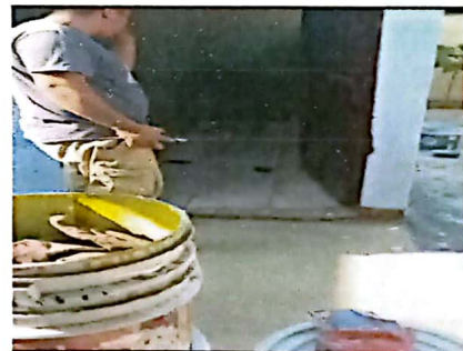
Foto 6: Iniciando la colocación del piso del aula del primer nivel
