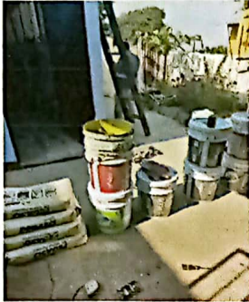
Foto 1: Material de pintura para dar inicio con el primer renglón
