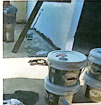
Foto 4: Pintando las aulas del segundo nivel
