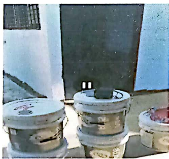
Foto 5: Pintando las paredes exteriores de las aulas
