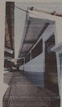
Foto 2: Vista de láminas troqueladas instaladas en la estructura.
